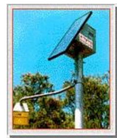
Đèn đường sử dụng năng lượng mặt trời
